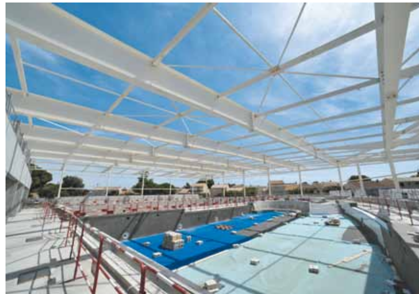
À Lattes, la pose de la toiture des Néréides s'achève en octobre.
