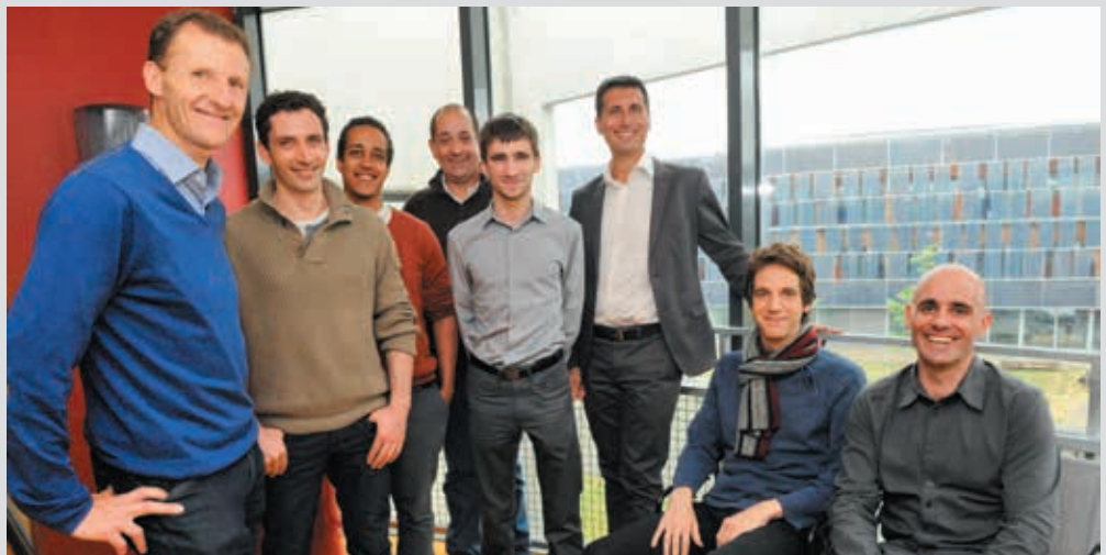
Gregory Lamotte, fondateur de Comwatt (à gauche) et son équipe, devant le MIBI et sa façade de panneaux solaires.
