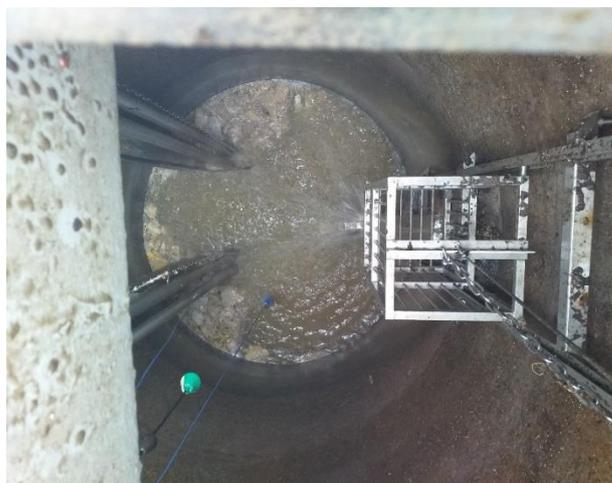
Figure 2 - PR Village - Saint-Drézéry - cuve avec panier dégrilleur
