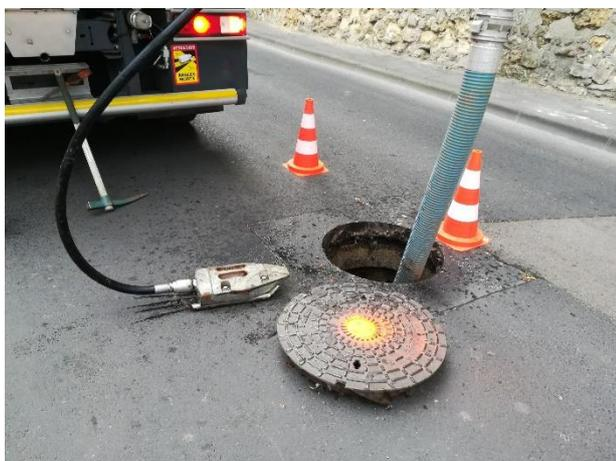
Un réseau de collecte doit périodiquement être curé pour supprimer les obstructions et maintenir un écoulement constant des effluents.
