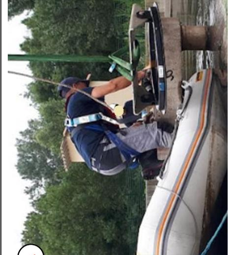
**1** : renouvellement de la pompe 2 sur le PR Village (poste refoulant à la station)
