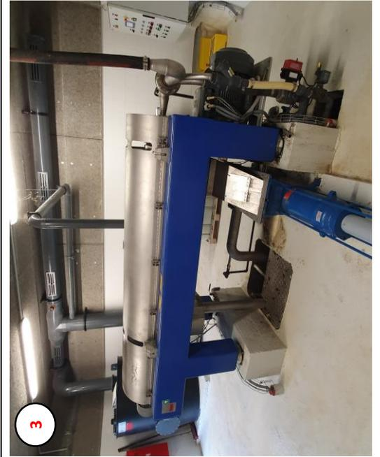
**1** : renouvellement de la pompe 1 d'extraction des boues vers le silo
