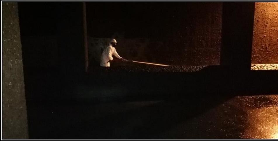
Du fait, de l'accumulation de matière dans la fosse de vidange et de l'impossibilité d'évacuer ces dépôts par les pompes, 2 interventions par an sont nécessaires avec un hydrocureur et 2 agents hydrocureurs.
