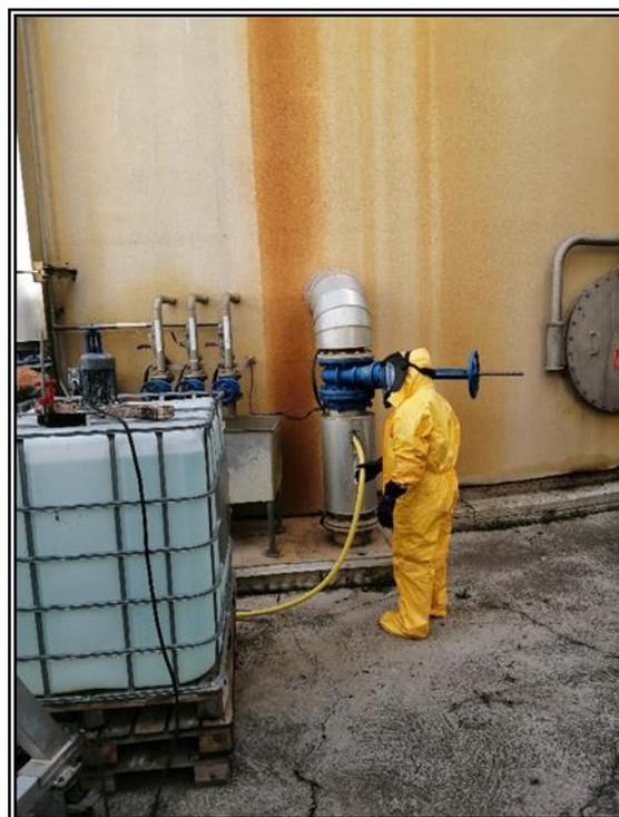
*Injection du lithium dans le digesteur n°2*
