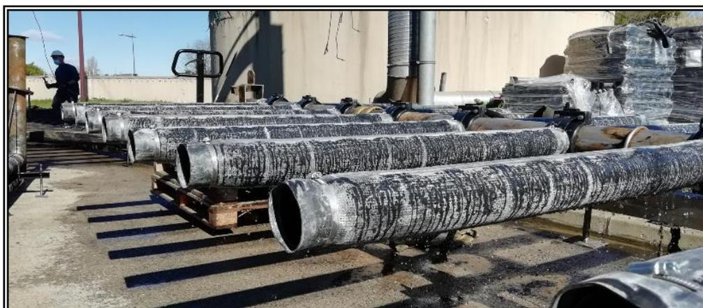
*Test en eau des rampes avec diffuseurs neufs*
