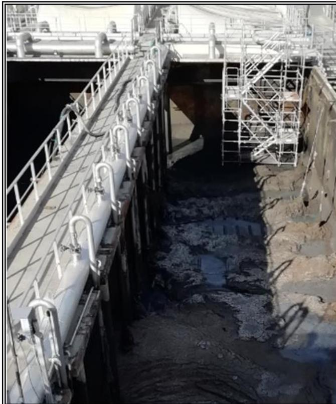
*Pose de l'escalier d'accès sécurisé grutable pour le bassin d'aération*
