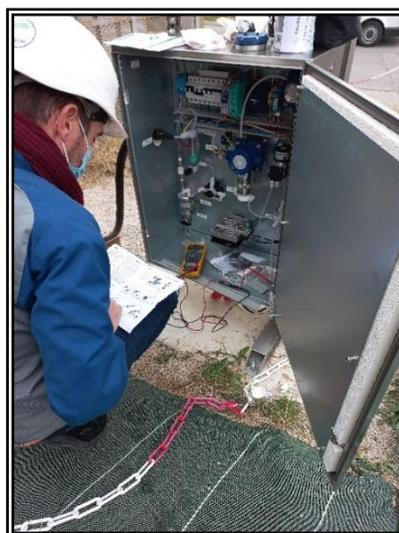
*Mise en service de l'analyseur en continu H2S dans le biogaz*
