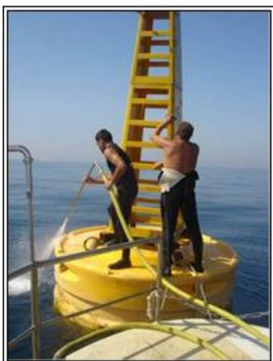
Sur la partie émergée de la bouée se trouve un panneau solaire alimentant un feu de signalisation. Un nettoyage avec tissu doux a été fait sur le panneau puis un contrôle du bon fonctionnement du feu.
