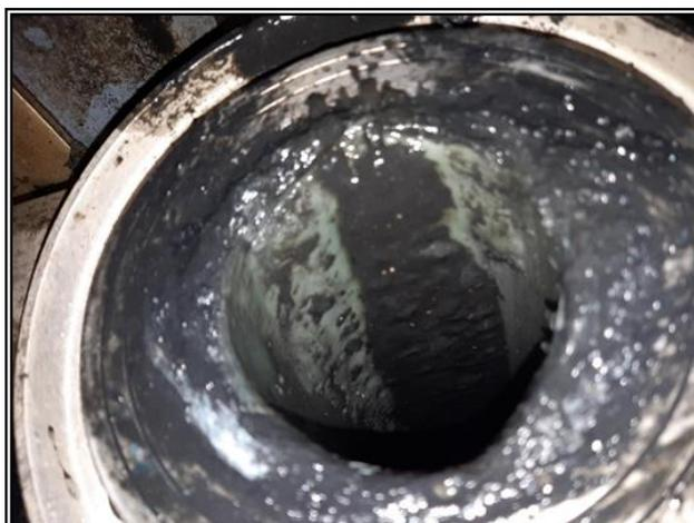
*Dépôts de calcite canalisation alimentation digesteur*
