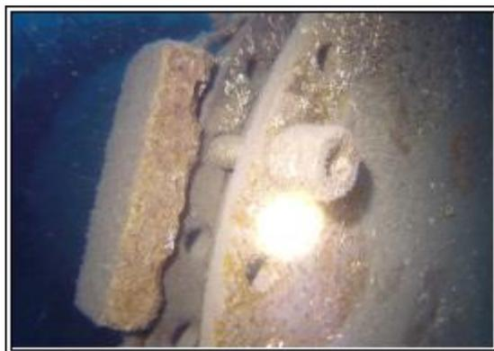
Anode installée sur la bride de la tête de l'émissaire, peu d'usure 10 %.
