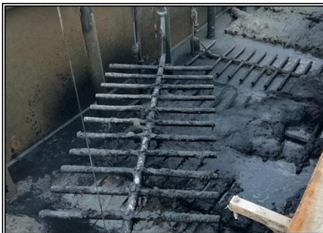
*Extraction des rampes du bassin d'aération et dépose sur l'aire de maintenance*
