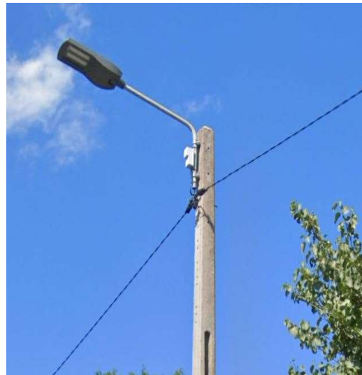
Réalisation sur poteau 3M
