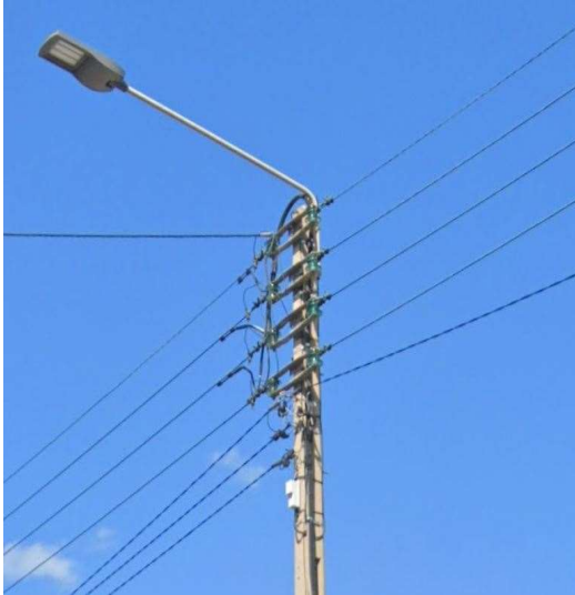
Réalisation sur poteau mutualisé
