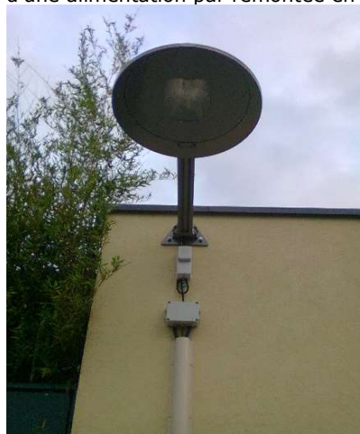
Exemple d'une alimentation par remontée en façade
