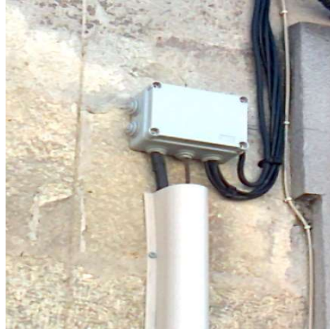
Remontée sur façade
